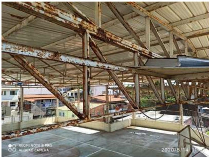
Foto 2: Estrutura corroída e desprendimento de telhas existentes.
