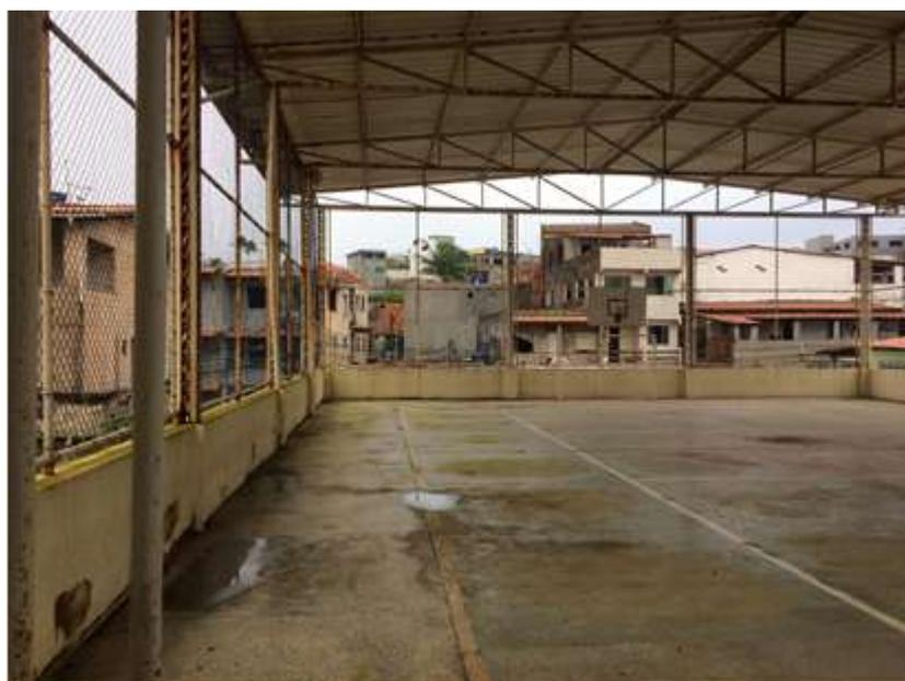
Foto 1: Cobertura em estrutura metálica existente, apresentando corrosões.
